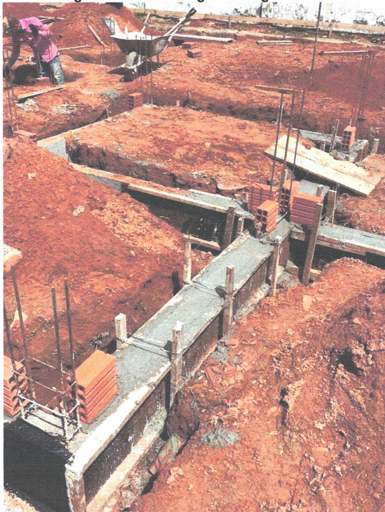
Imagem 08 – Concretagem da viga baldrame
