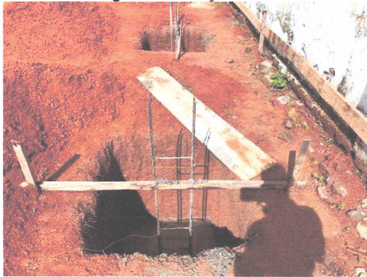
Imagem 03 – Escavações das sapatas
