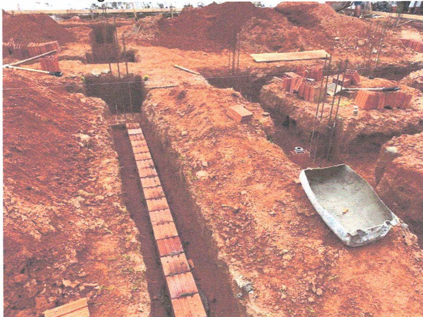
Imagem 07 – Alvenarias de embasamento
