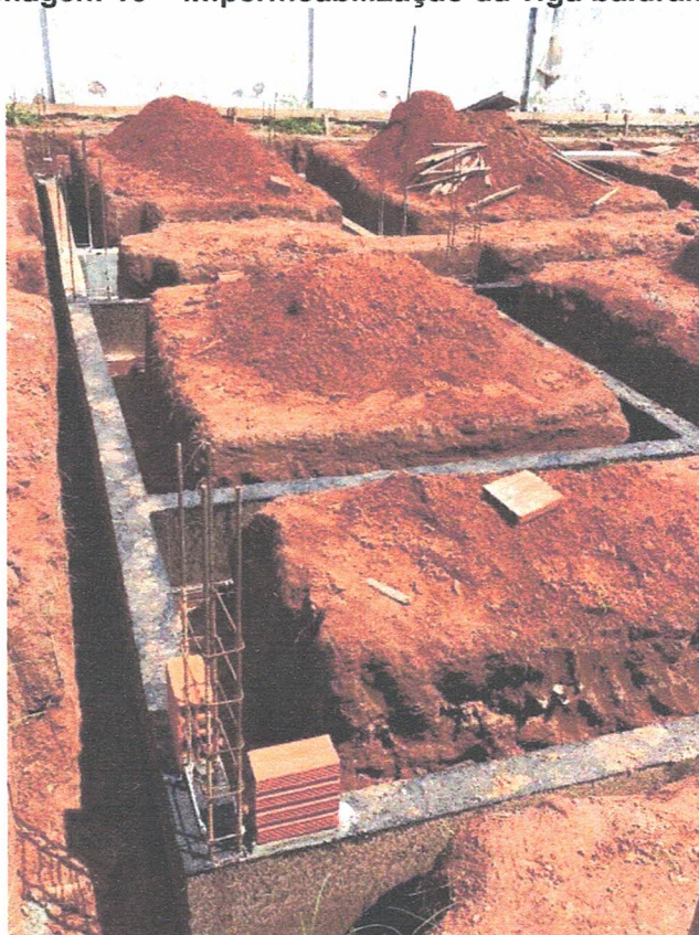
Imagem 10 – Impermeabilização da viga baldrame
