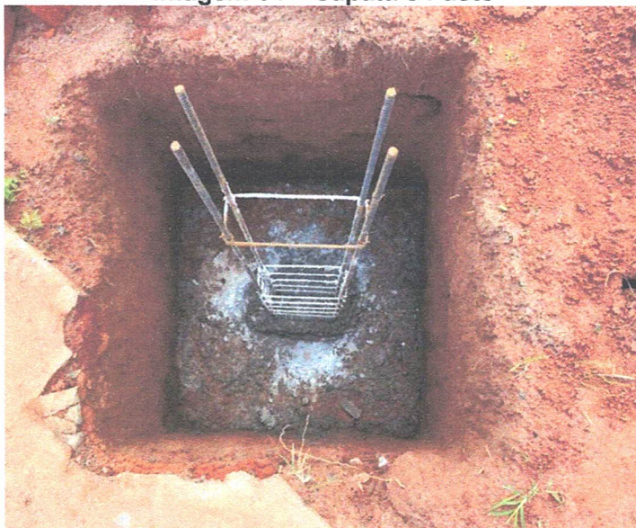
Imagem 05 – Escavações das alvenarias de embasamento
