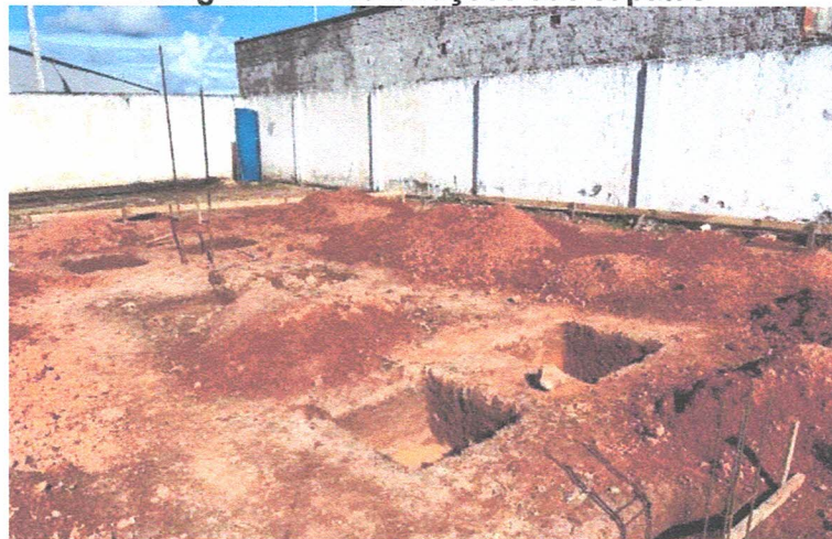
Imagem 03 – Ferragem das sapatas
