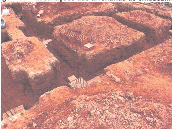
Imagem 06 – Escavações das alvenarias de embasamento
