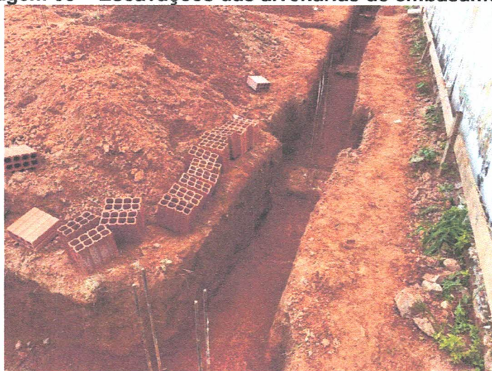
Imagem 06 – Escavações das alvenarias de embasamento
