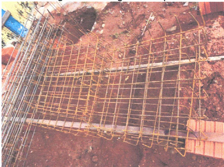
Imagem 03 – Ferragem das sapatas
