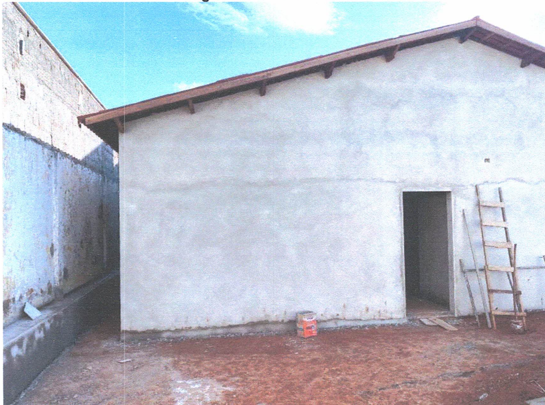
Imagem 03 – Reboco externo
