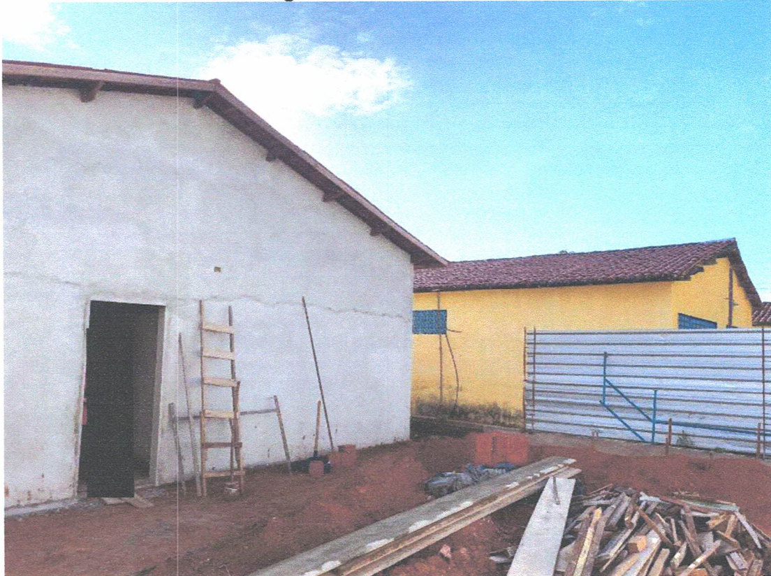
Imagem 02 – Reboco externo
