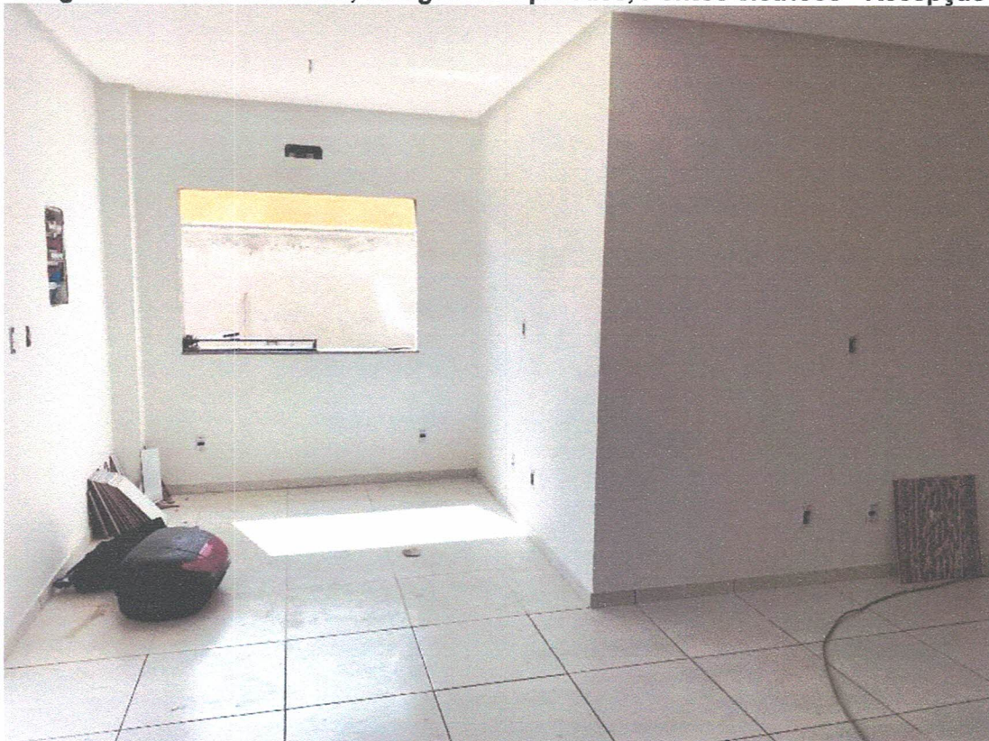
Imagem 11 – Piso cerâmico, Selagem das paredes, Pontos elétricos - Recepção
