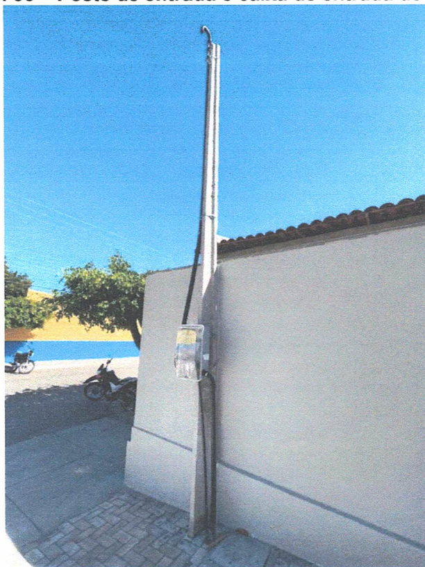
Imagem 36 – Caixa de entrada de energia
