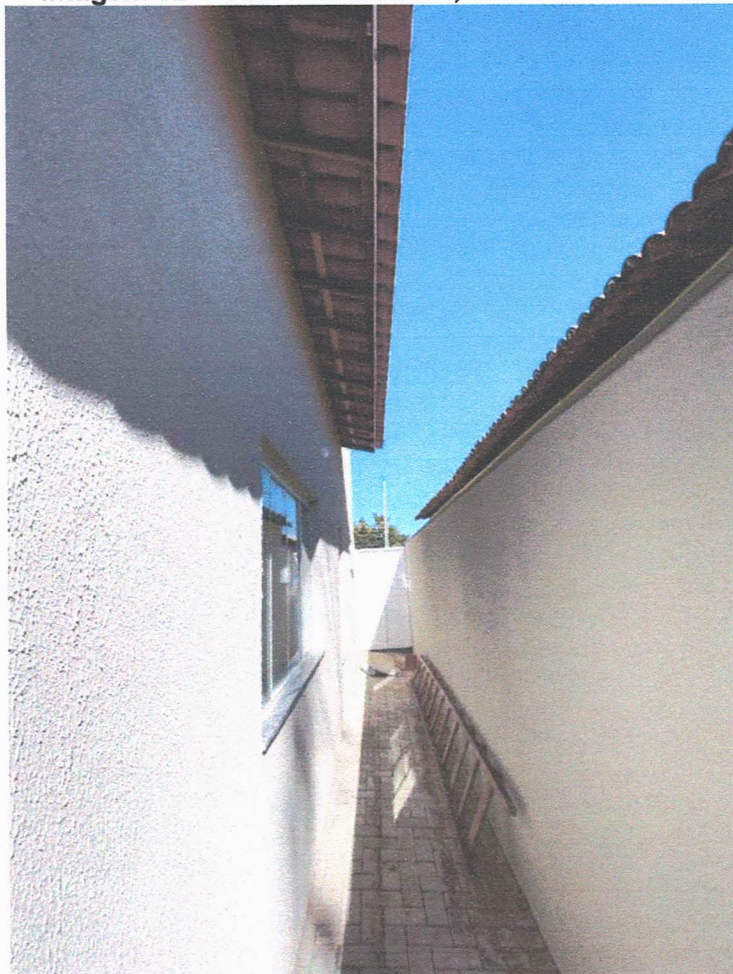
Imagem 32 – Corredor externo, beiral de madeira
