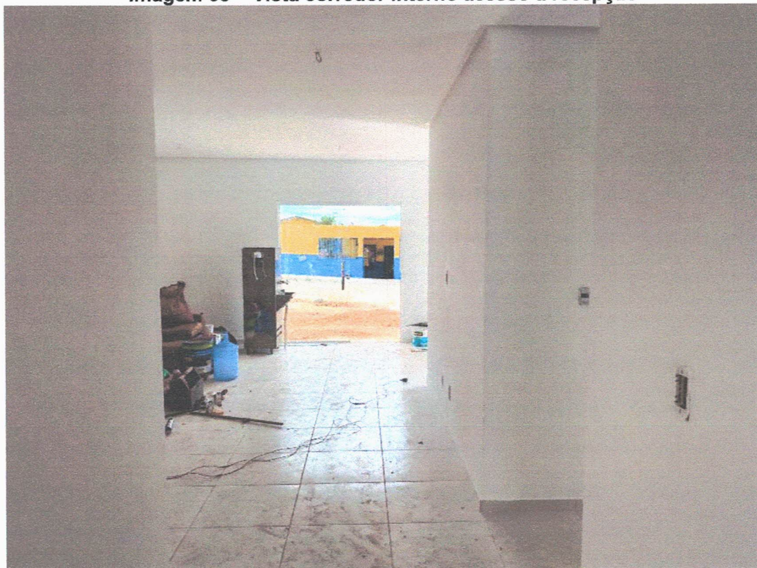
Imagem 03 – Vista corredor interno acesso a recepção
