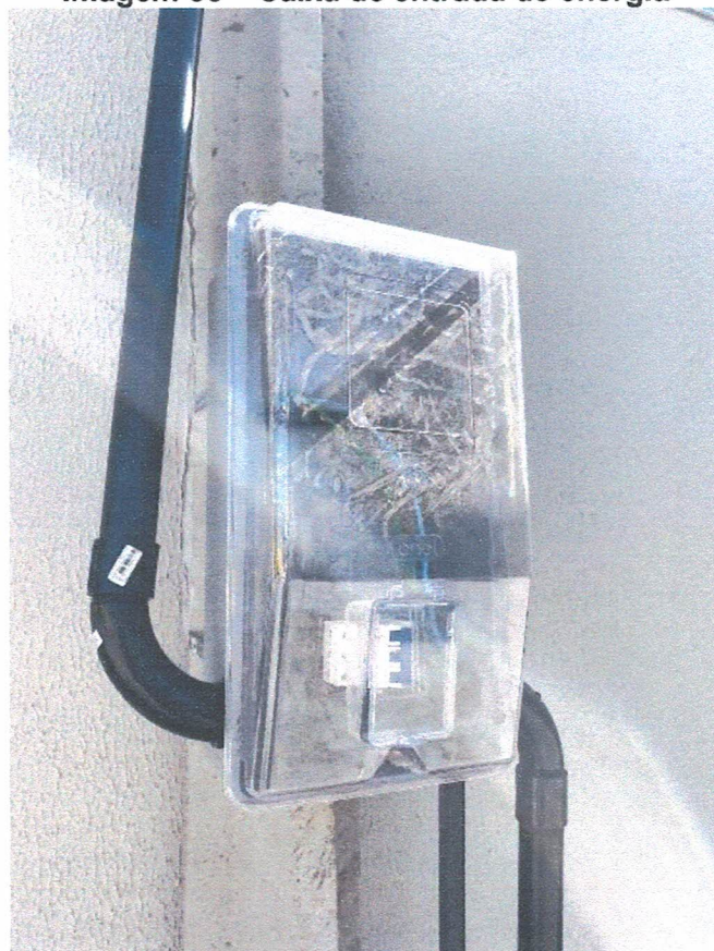
Imagem 36 – Caixa de entrada de energia
