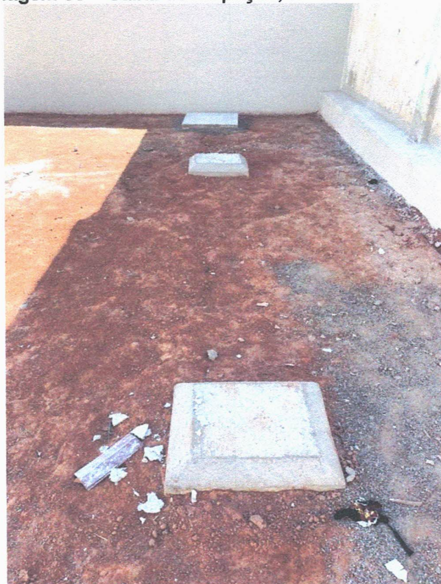
Imagem 38 – Caixa de inspeção, fossa e sumidouro
