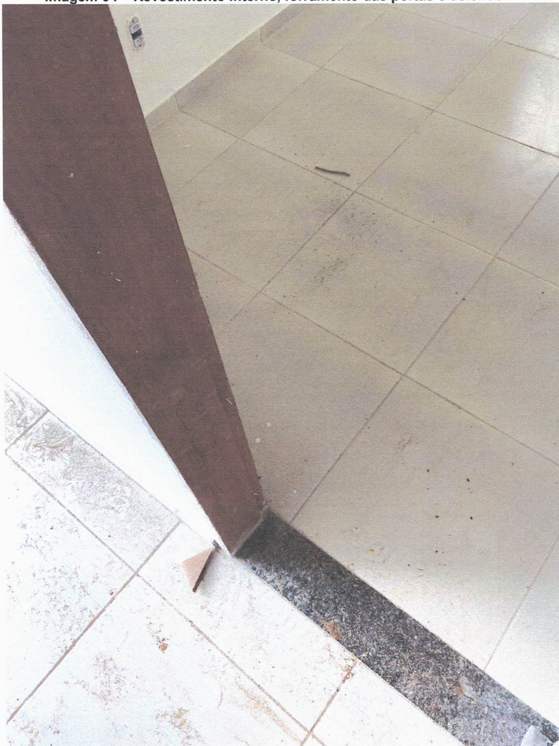
Imagem 04 – Revestimento interno, forramento das portas e soleiras
