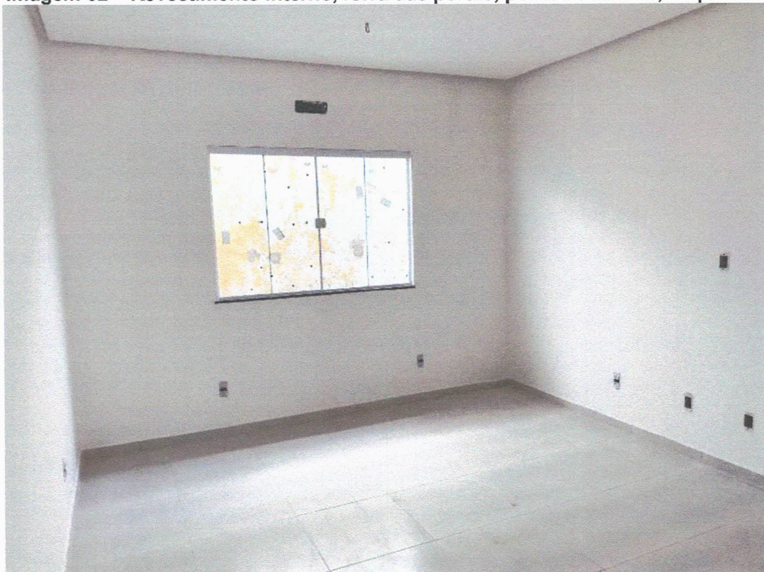
Imagem 02 – Revestimento interno, forra das portas, pontos elétricos, esquadria
