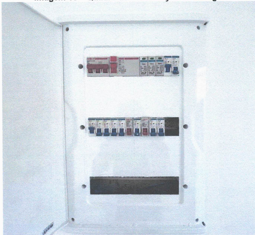
Imagem 16 – Quadro de Distribuição de Energia
